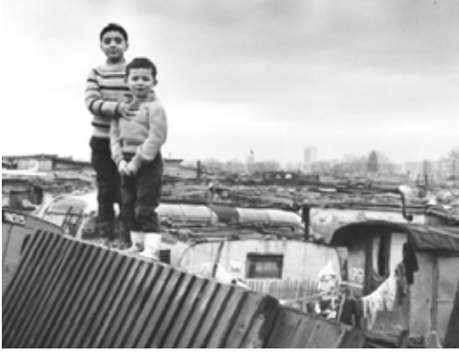
Bidonville de la Campa St-Denis - La Courneuve 1965 - 1966 600 familles, un robinet pour 2000 personnes. Ce sont les logements de ceux qui construisent tout ce que nécessitent les trente années dites glorieuses...
